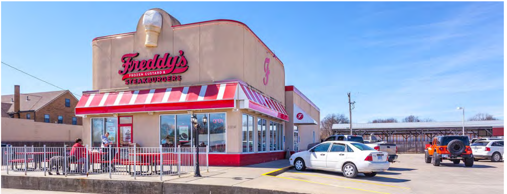
ACTUAL SITE PHOTOS
